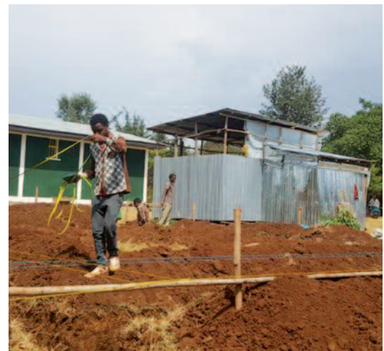
Inizio lavori fundamenta cucina e mensa a Laku (Etiopia)
